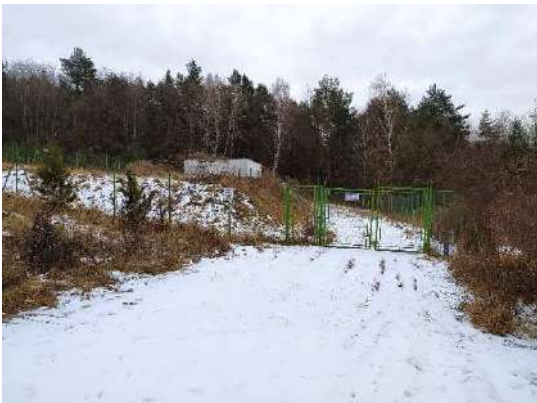
Obr. č.23 vodojem VZO-9
