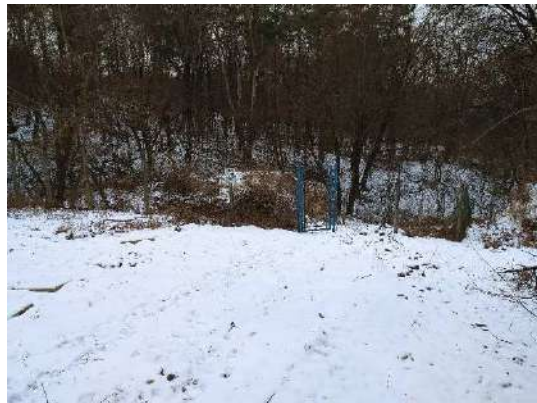
Obr. č.24 vodojem VZO-10
